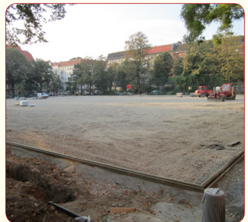
Auf dem Innsportplatz geht es endlich voran: Die Bauarbeiten sollen hier bis Ende des Jahres abgeschlossen sein.
